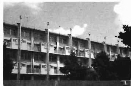
写真2 建物全景(北側)
