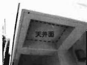
写真4 コンクリート天井面
