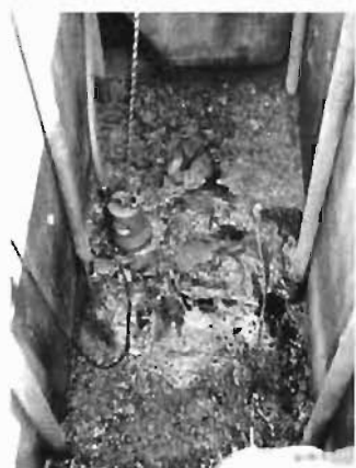
写真3 漏えい後、地下水と混ざった灯油
