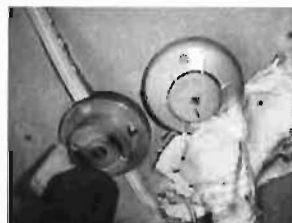
写真10 実験後のC室内住警器（煙式）（拡大）
