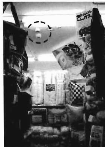
図3 設置状況 (S店舗)
