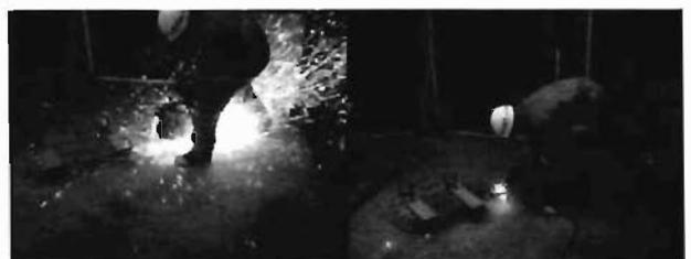
写真16 グレーチング切断風景
