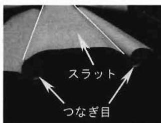
写真22 シャッターの構造
