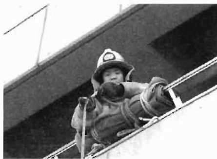
写真3 ホース吊り上げ
