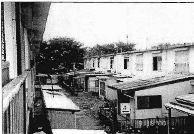
写真1 実験棟の状況
