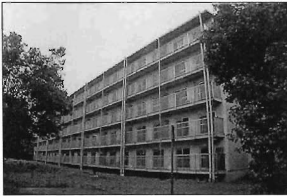
写真1 実験棟の状況(南側)
