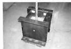
写真1 立て配管の固定状況
