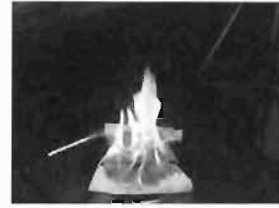
写真 12 電源遮断から 60 秒後、着火した状況
