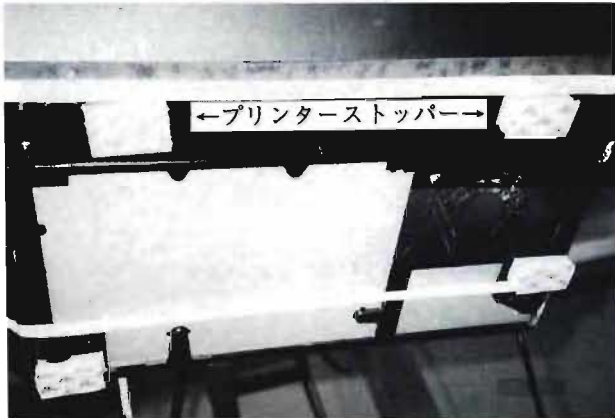
写真7 プリンタストッパーの設置状況
