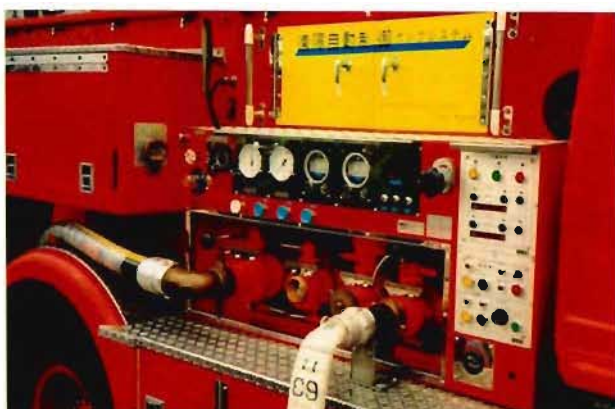
写真2 コントロールパネル
