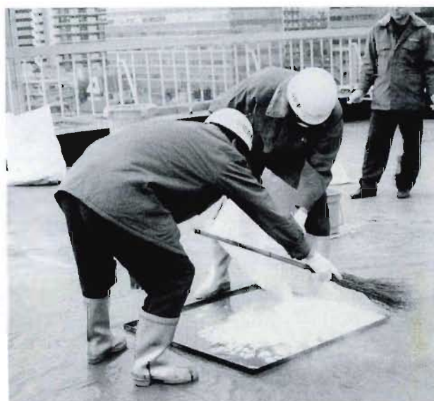
写真3 パーライトの作業試験
