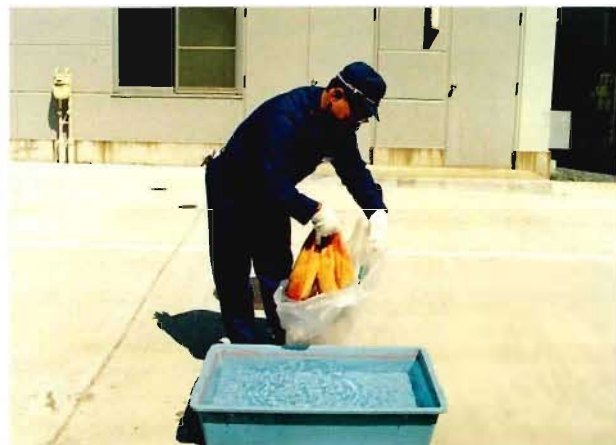
写真7 油吸収マット回収時の状況
