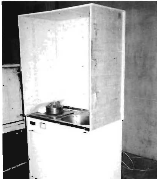
写真 4 キッチン上部は石膏ボード (9mm)
