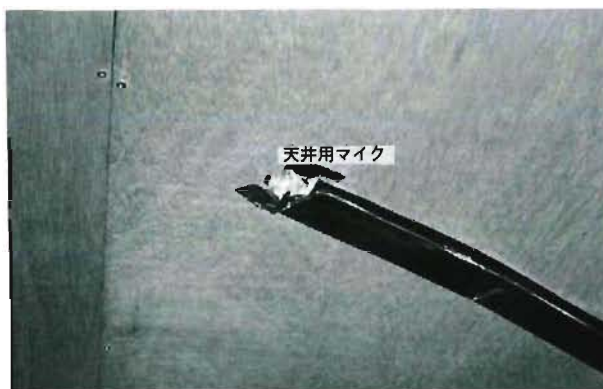
写真1 天井用マイクの設置状況
