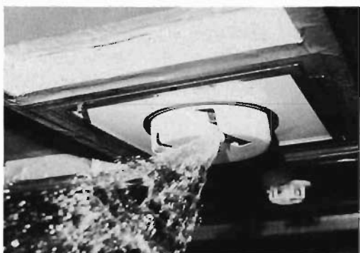
写真4 住宅用スプリンクラー装置 (2軸方式)
