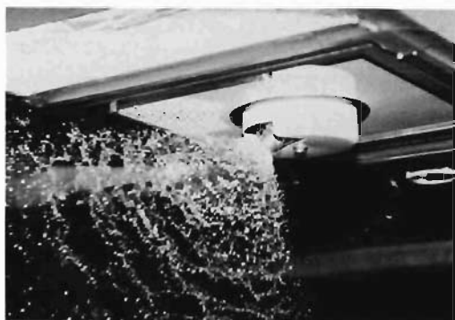
写真3 住宅用スプリンクラー装置 (1軸方式)
