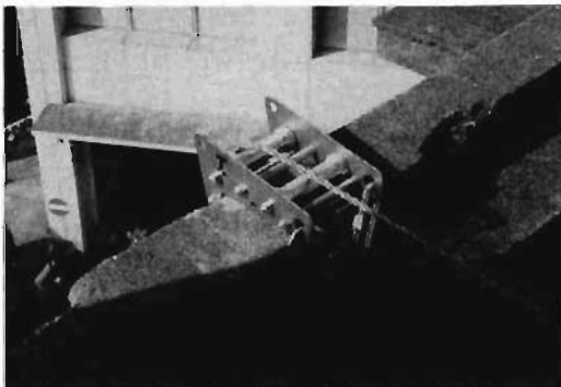
写真1 突りょう(写真下：ガイドローラー)
