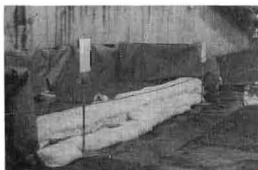
写真24 工法完成時の状況
