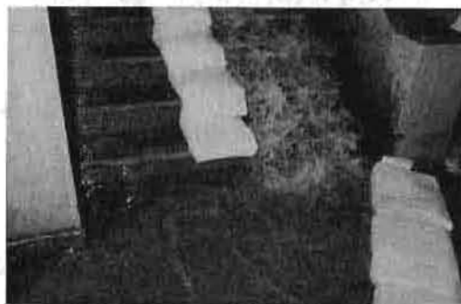
写真29 階段の排水状況
