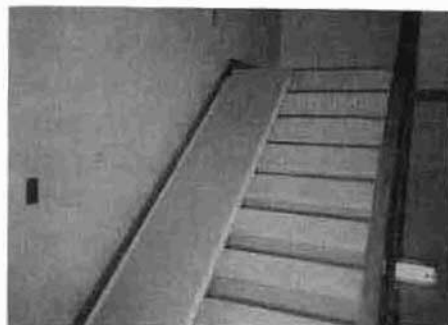
写真7 スロープの状況
