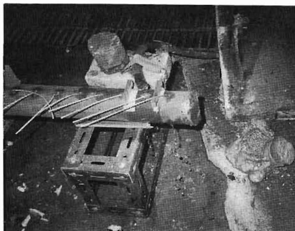
写真2 冷却しながら酸素ヤリにより棒鋼を溶断した状況
