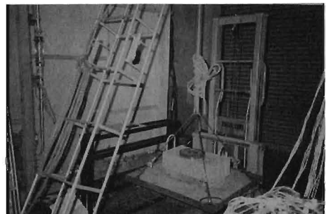
写真4 限界荷重試験
