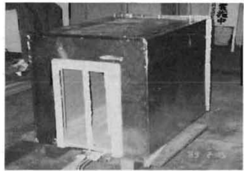
写真2 内装材補強状況
