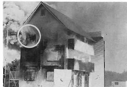
写真8 三階居室F・O発生前（開口部から褐色の煙が大量に噴出している状況）
