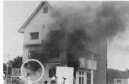
写真5 一階居室のF・O発生後の状況
