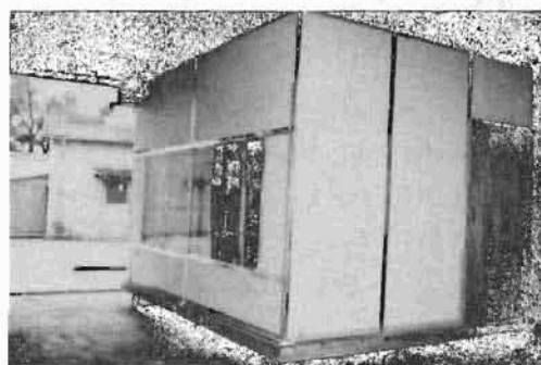
写真1 模擬ハウスの状況
