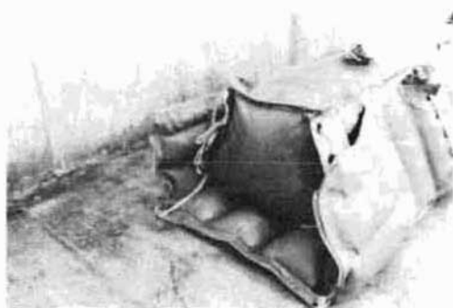
写真4 水のう連結部の状況
