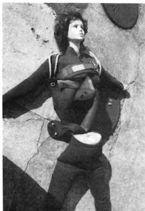
写真9 腰部の損傷状況
