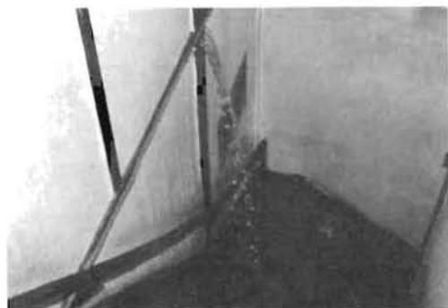
写真1 階段室内漏水状況
