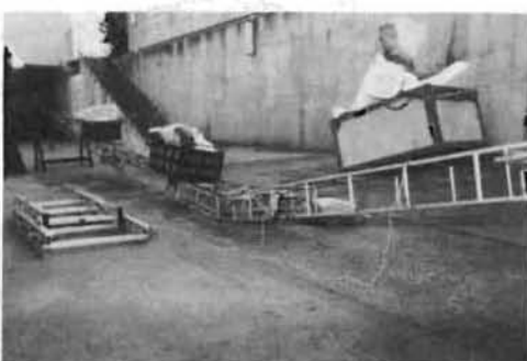
写真9 同上破壊状況
