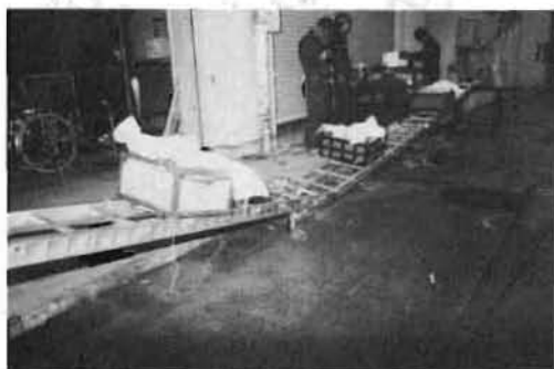
写真5 同上破壊状況
