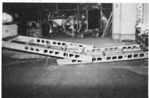
写真6 同上破壊状況(はしご右側から撮影)
