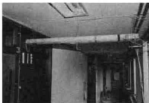
写真4 煙濃度計設定状況
