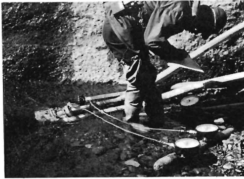
写真3 貯水池に高落差ポンプを投入した状況
