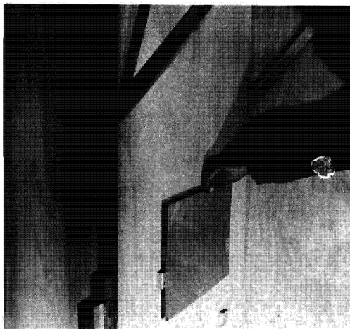
写真9 防熱板の取り外し
