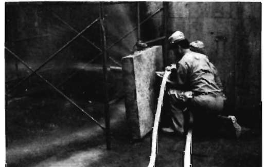
写真5 コンクリート壁体の穿孔状況
