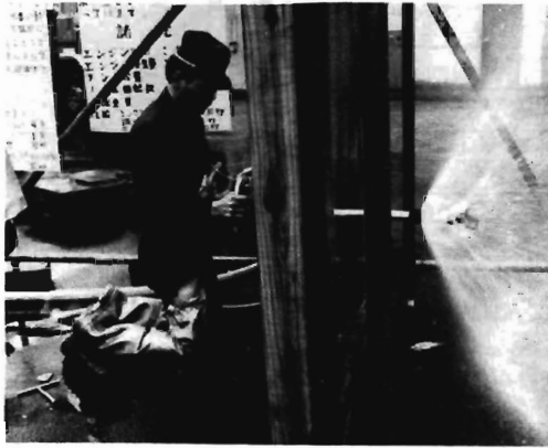
写真3 モルタル壁体の穿孔状況
