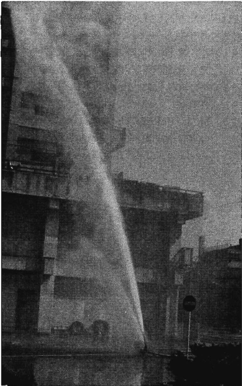
写真1 自動水幕装置
