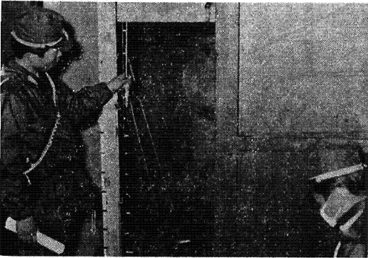
写真3 風速測定状況
