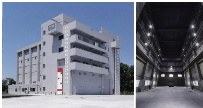
写真 中層訓練棟の外観及び実火災訓練スペース
