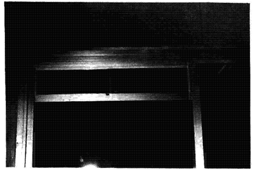
写真4 サッシ窓上部の換気窓(左右スライド式)
