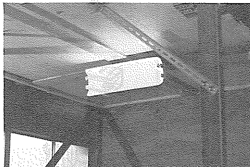
写真4 器具が激しく天井に当たる
