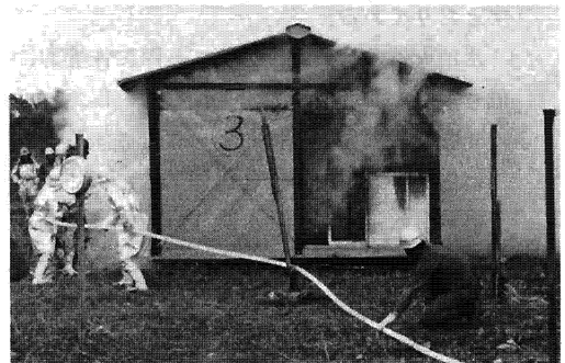
写真7 木造平家建(20㎡)住宅火災の消火実験 点火後9分、窓から炎が噴出
