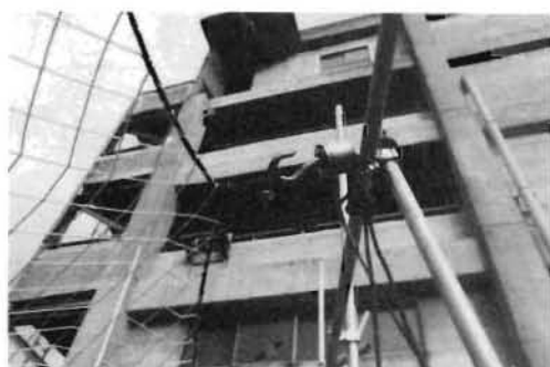
写真3 ネット辺部中央に荷重変換器を取り付けた状況
