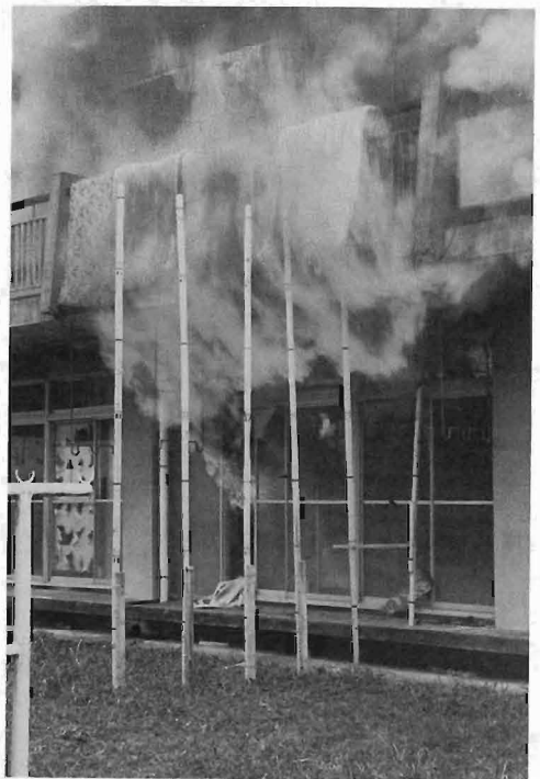
写真1 F・O発生に伴う火炎の噴出状況(東村山実験)
