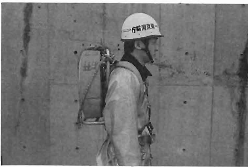
写真6 背負子による資器材積載状況
