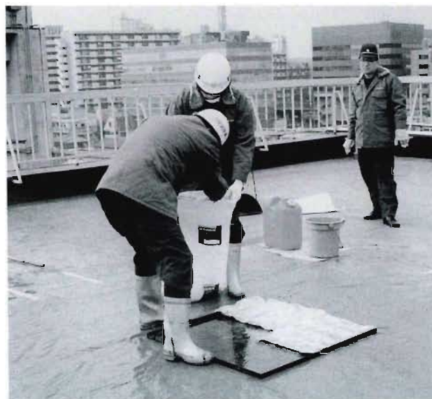
写真2 油吸収マットA型の作業試験
