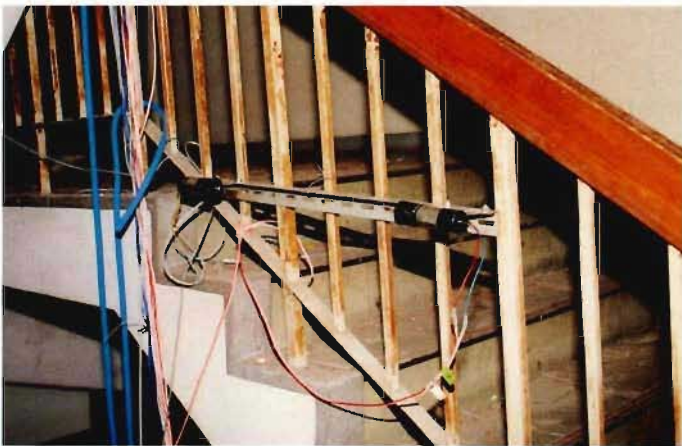
写真3 階段の測定点
