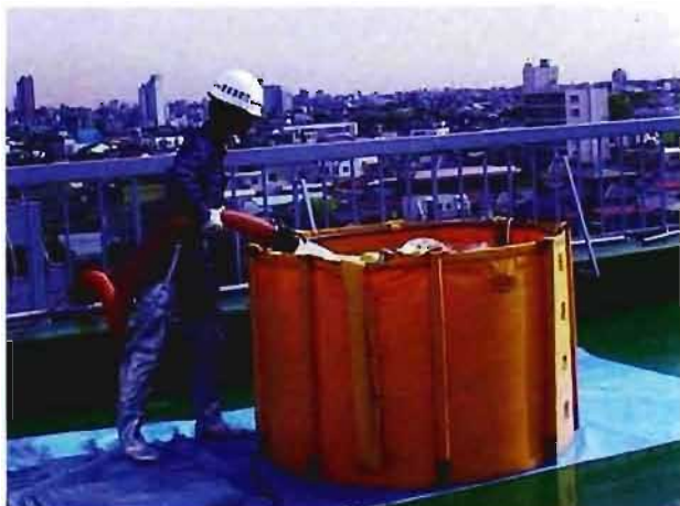
写真5 屋上で水槽に充水しているところ
