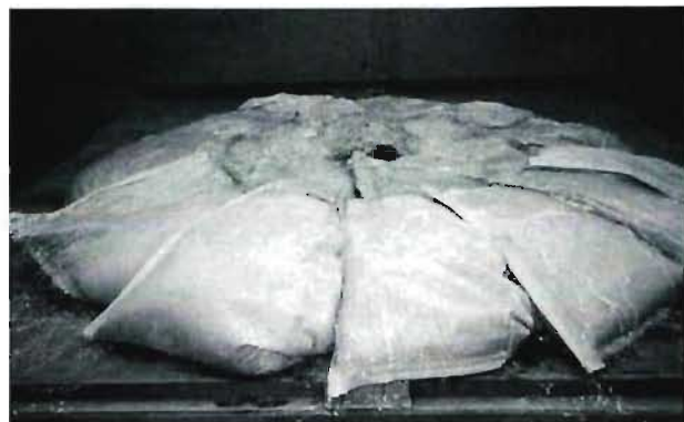
写真9 土のうにより損壊路面上に設定した流出口
