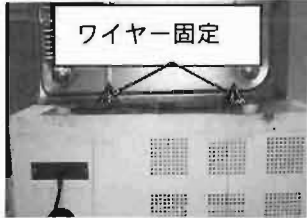
写真9 レンジをワイヤーで取り付けた状況
