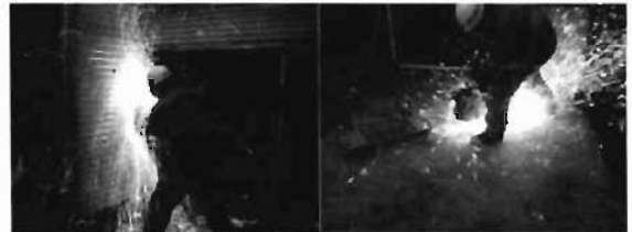
写真29 火花の発生(エンジンカッター)
