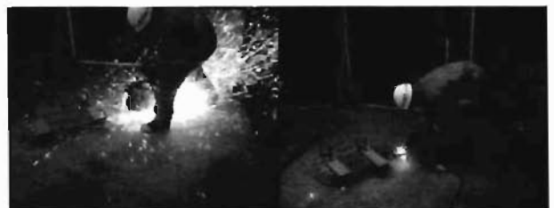
写真16 グレーチング切断風景
