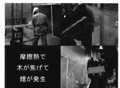
写真24 木材切断状況 (エンジンカッター)
