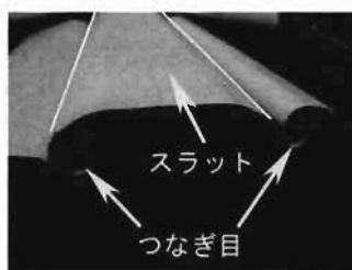
写真22 シャッターの構造
