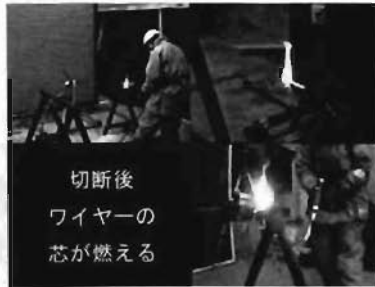
写真25 ワイヤ切断状況 (プラズマ金属加工機)
