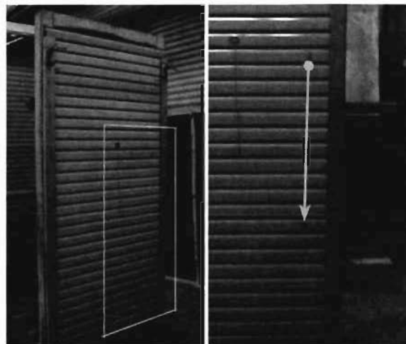
写真7 シャッター(矢印:切断位置、方向)
