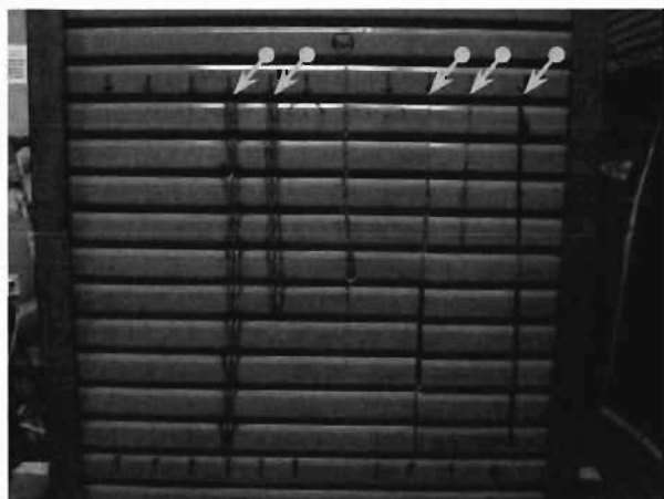
写真17 シャッター切断状況
