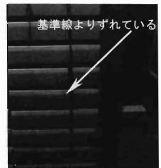
写真30 シャッター切断跡
