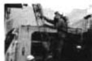
写真10 壁紙剥がし
