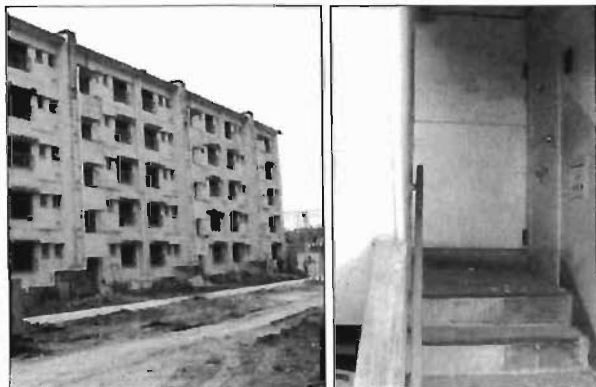
写真4 実験建物外観及び玄関付近の状況
